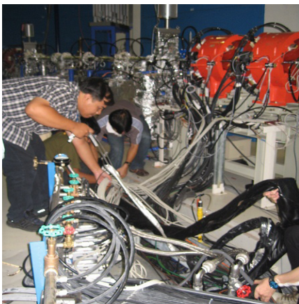
รูปที่ 2 แสดงการติดตั้งอุปกรณ์ต่างๆ และระบบกราวด์ภายในวงกักเก็บอิเล็กตรอน(เดิม)
